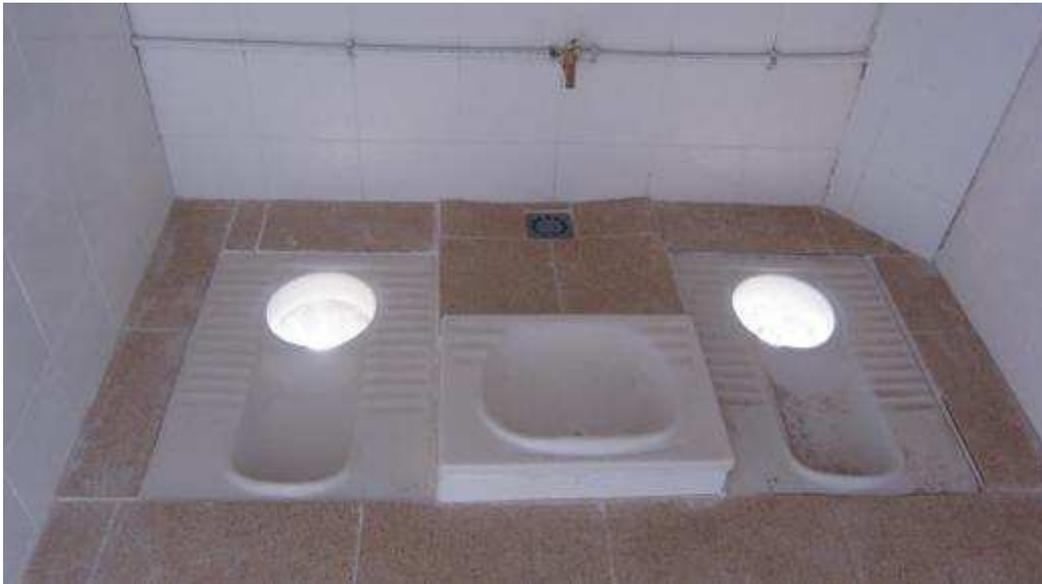
Les toilettes sèches installées à Tagounite par l'association Microbiona permettent de séparer les déchets solides et liquides.
