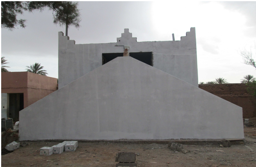
Toilettes écologiques de l'Ecole Asrir en cours de finition
