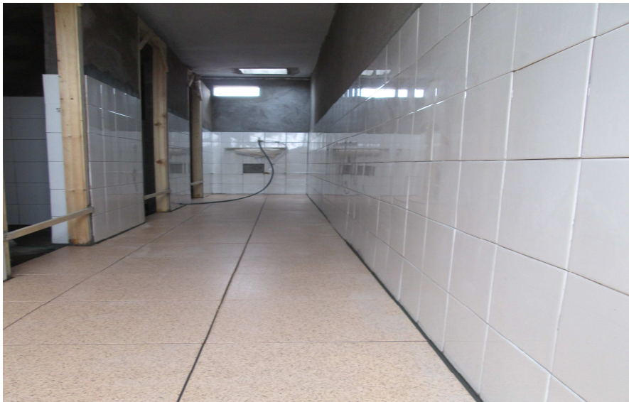
L'intérieur des toilettes écologiques en cours de finition
