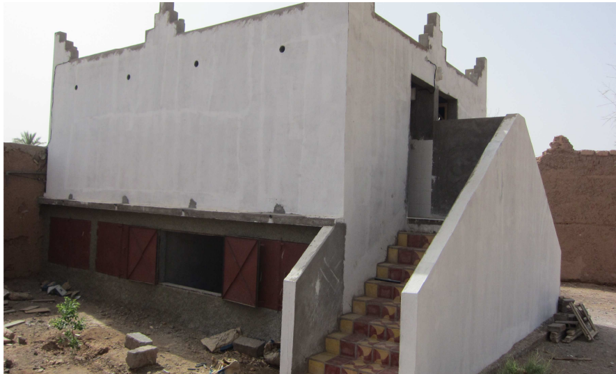
Toilettes écologiques de l'Ecole Asrir en cours de finition
